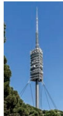
4. **Atirantar** la estructura para evitar que vuelque (con tirantes se aumenta el radio de la base).
